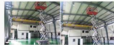
시스템 조명 설치
